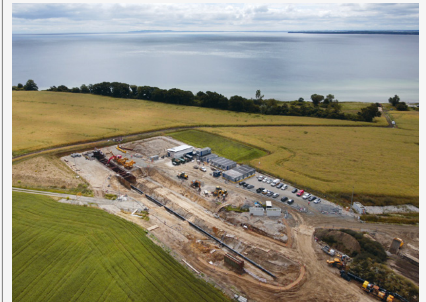
Verbindung der Offshore-Pipeline mit Onshore-Pipelines (bekannt als Tie-in) in Polen und Dänemark (Bild: baltic-pipe.eu)
